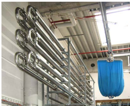
Wärmerückgewinnung Schmutzwasser / Wasser
