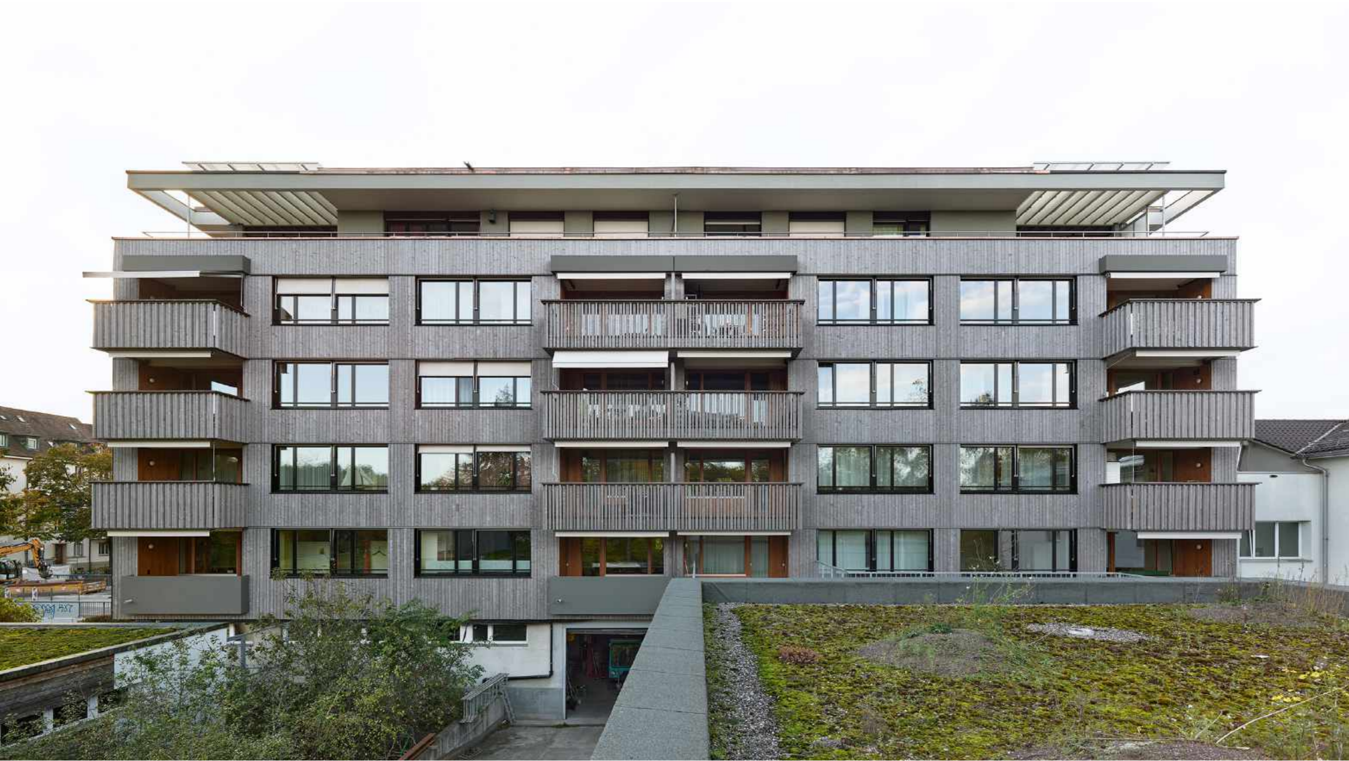
Sanierung Mehrfamilienhaus Oberwilerstrasse, Bild Roman Weyeneth
