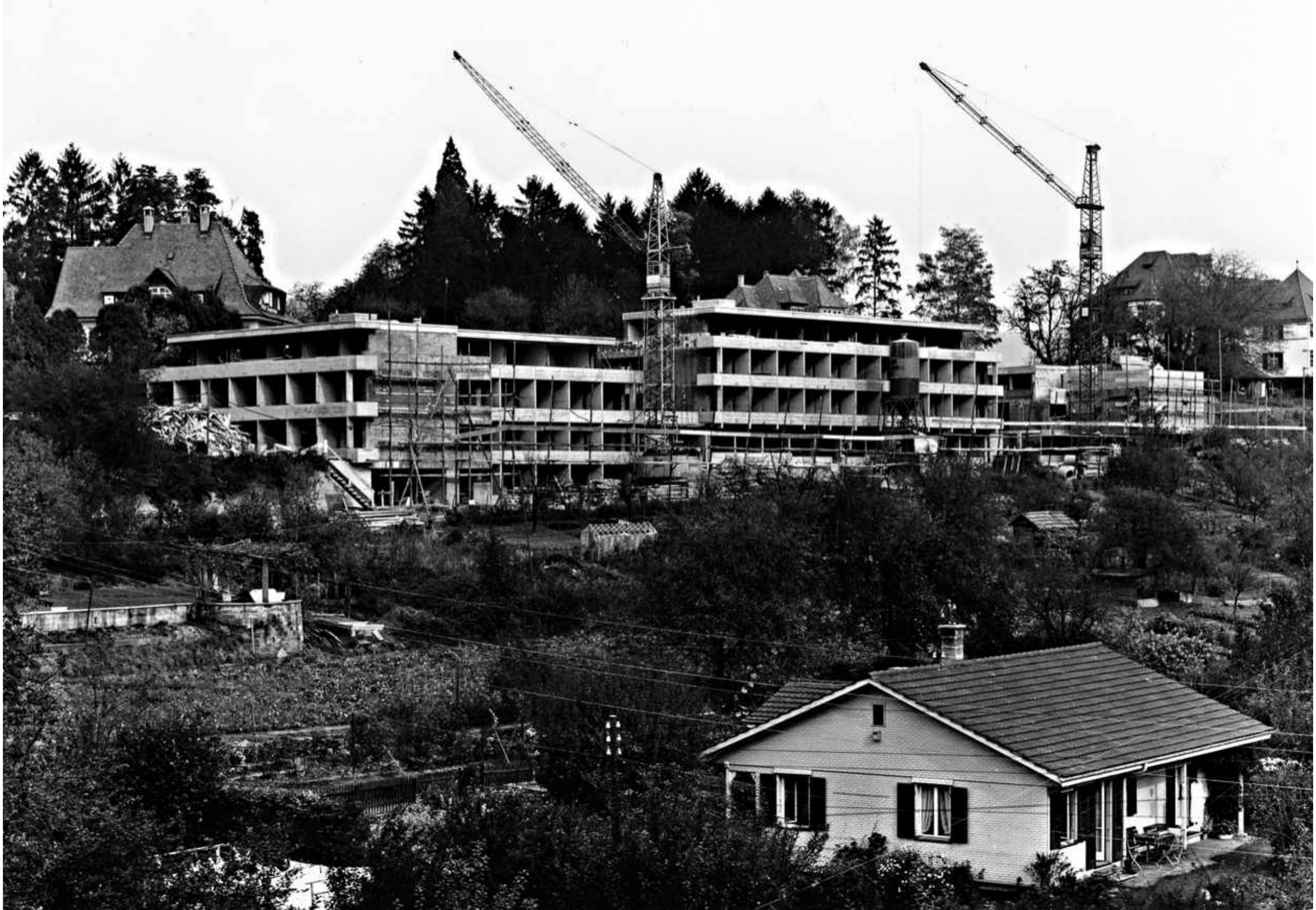
Umbau Dominikushaus Riehen (Bestand 1968) , Studienauftrag und Umbau 2022 - 2025
