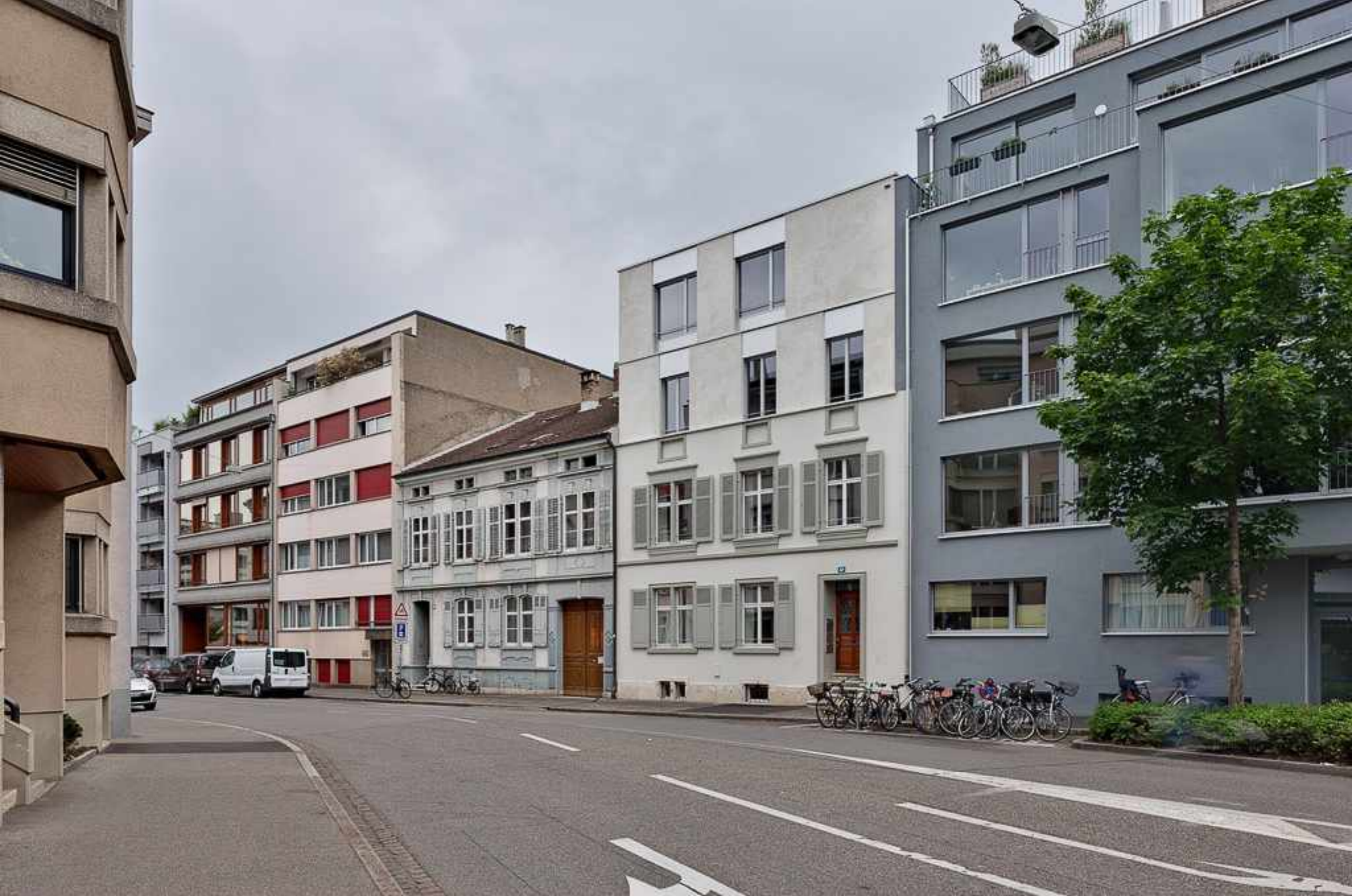
Aufstockung Birmannsgasse, 2026 sabarchitekten (Bild Michael Fontana)
