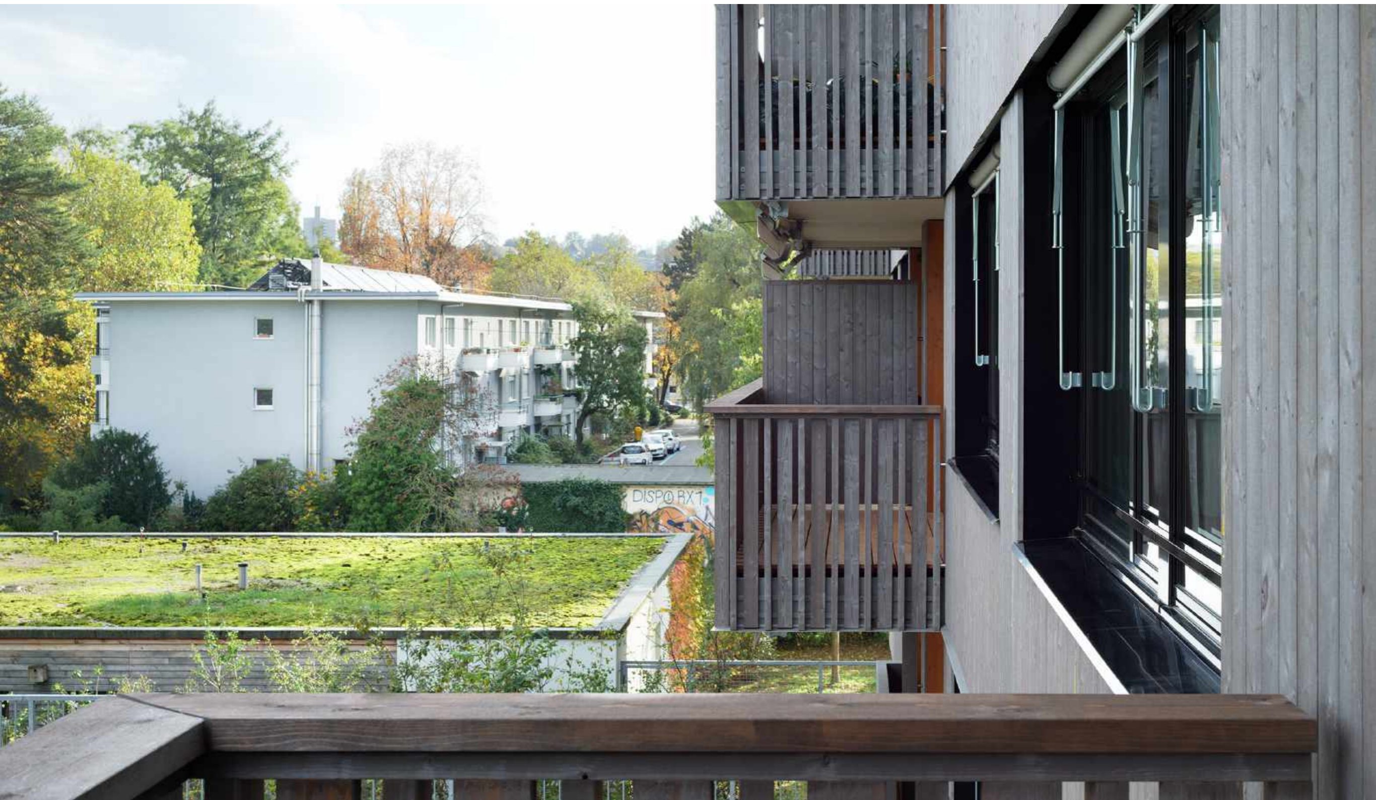
Sanierung Mehrfamilienhaus Oberwilerstrasse, Bild Roman Weyeneth
