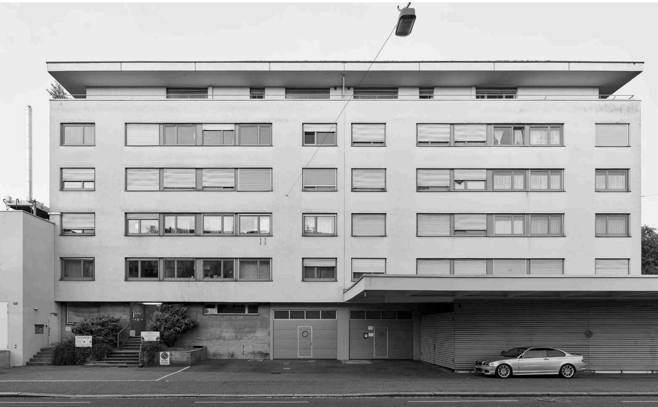
Sanierung Mehrfamilienhaus Oberwilerstrasse, Basel Bestand (1968)
