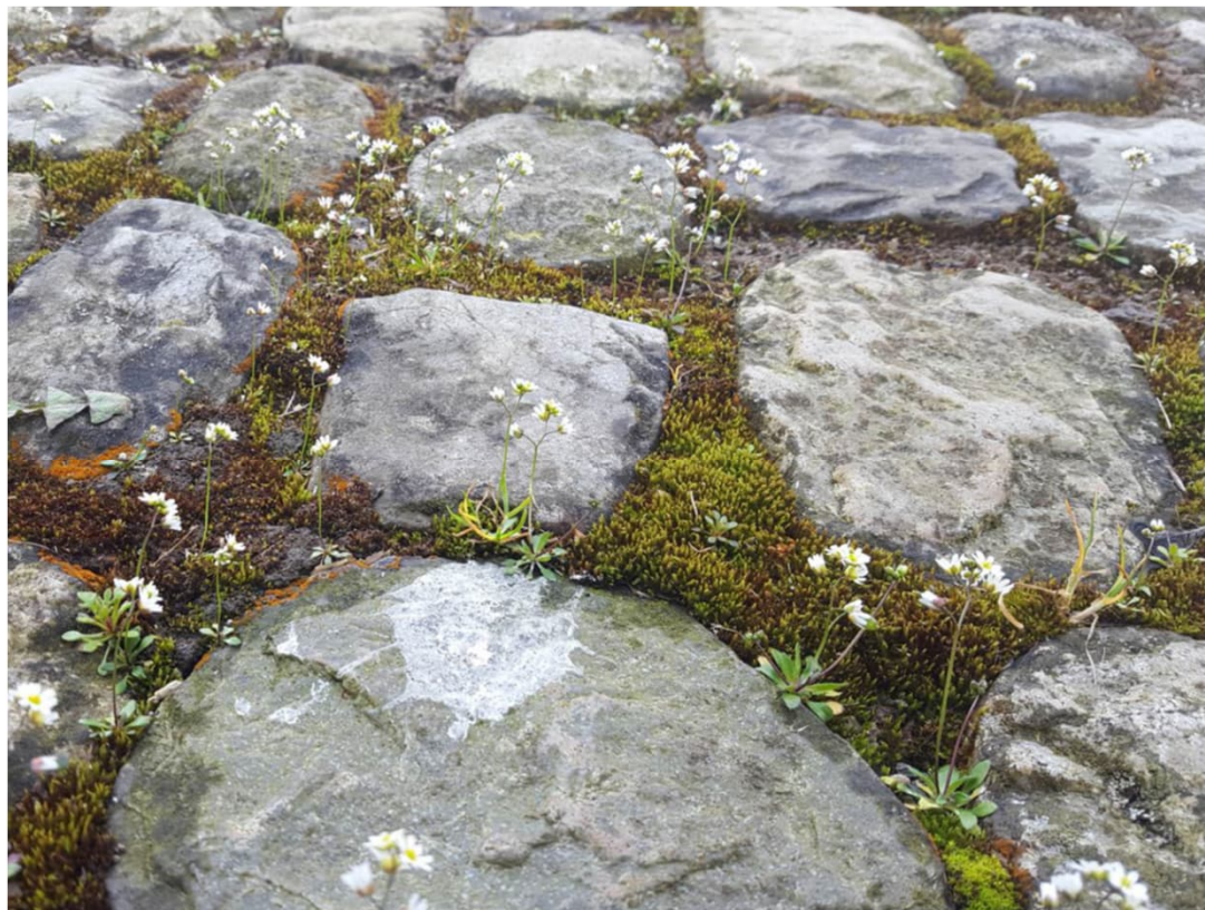
Sickerfähiger Beläge reduzieren den Oberflächenabfluss, Pflastersteine mit «Grünfugen». (© Sebastian Meyer)
