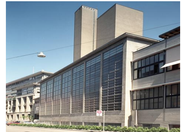
Fernheizkraftwerk ETHZ 56 MW, stillgelegt 2011
