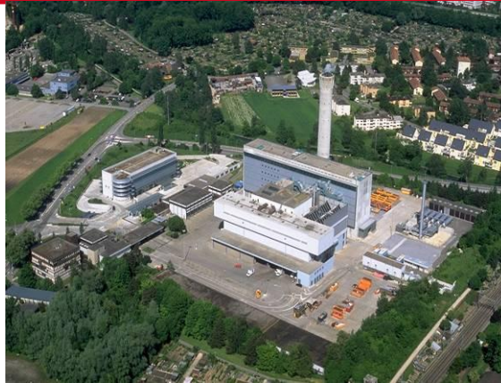
Kehrichtheizkraftwerk 2 Hagenholz 96 MW
