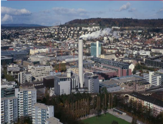
Kehrichtheizkraftwerk 1 Josefstrasse 99 MW
